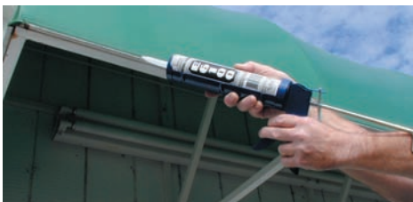
Instalar parasoles y toldos.
