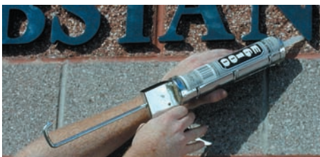
Instalar letreros acrílicos y metálicos.
