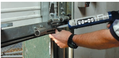
Reparar e instalar puertas enrollables levadizas.
