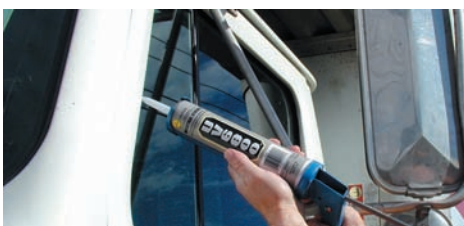
Adherir burletes a las ventanas.
