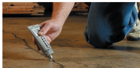
Sellar grietas en pisos de cemento.
